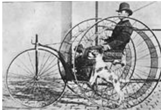
Figura 73. La cinoesfera es una invención francesa de finales del siglo XIX que utilizaba perros para mover sus ruedas. La misma utilizaba dos perros, cada uno impulsando una rueda distinta. Las máquinas y motores impulsados por perros de la época victoriana https://www.anfrix.com/2019/09/las-maquinas-impulsadas-por-perros-de-la-epoca-victoriana/?utm_content=cmp-true#google_vignette
