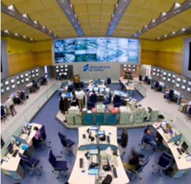
Centro de control de tráfico Ministerio del Interior
